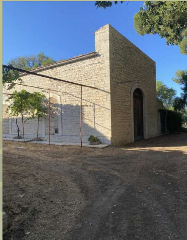
35. Vista verso lo stabilimento un tempo adibito a cantina vinicola
