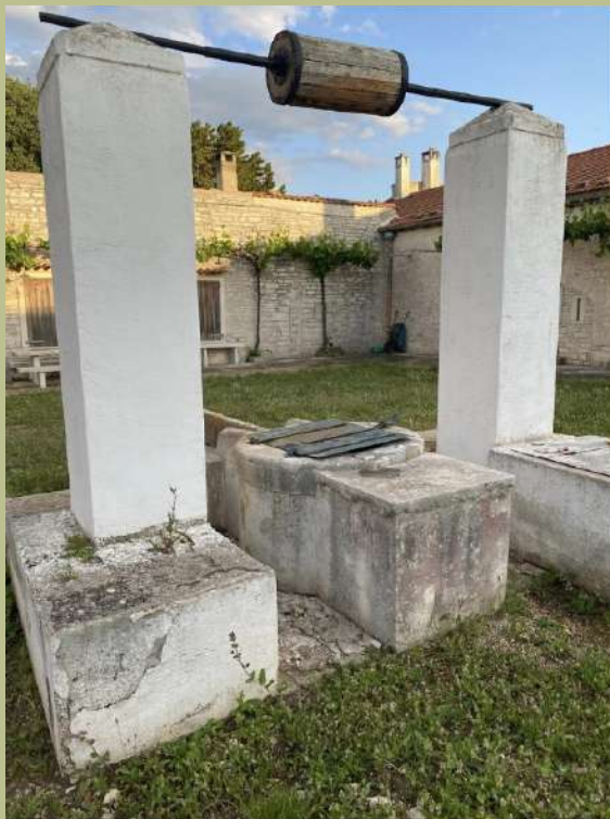
18. Cisterna a sinistra (entrando nella corte), vista posteriore
