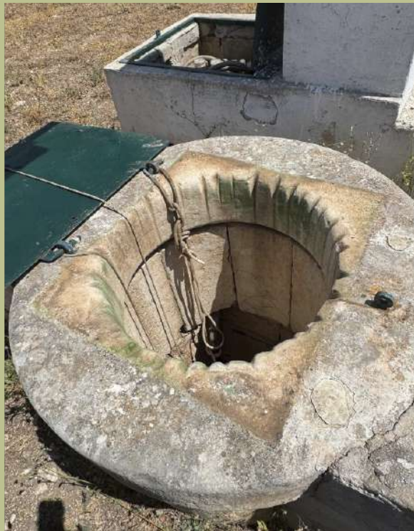
15. Cisterna a destra (entrando nella corte), la bocca del pozzo
