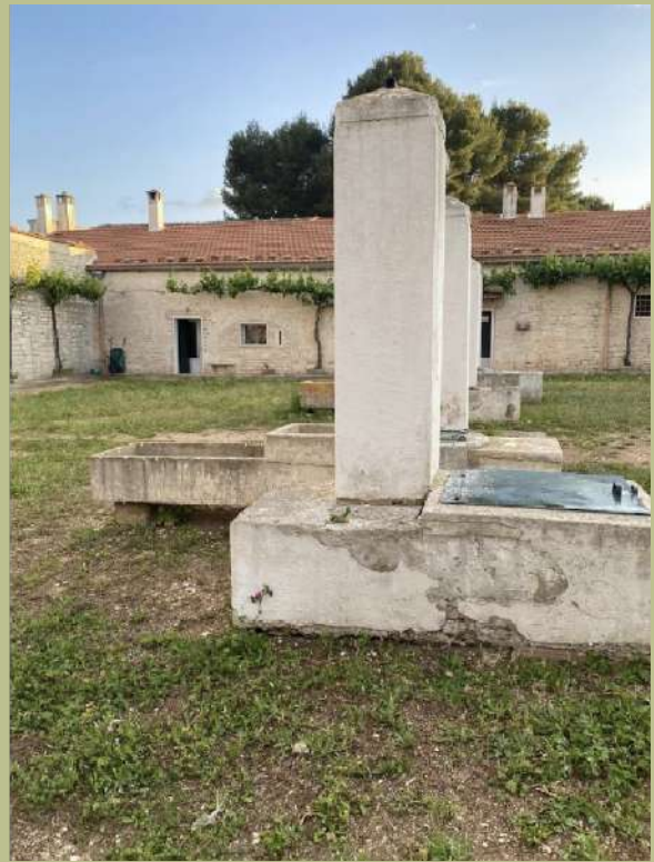
13. Cisterna a destra (entrando nella corte), vista laterale
