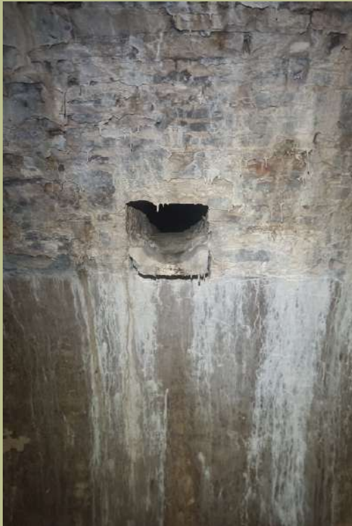
25. Particolare della bocchetta posta sul lato nord della cisterna
