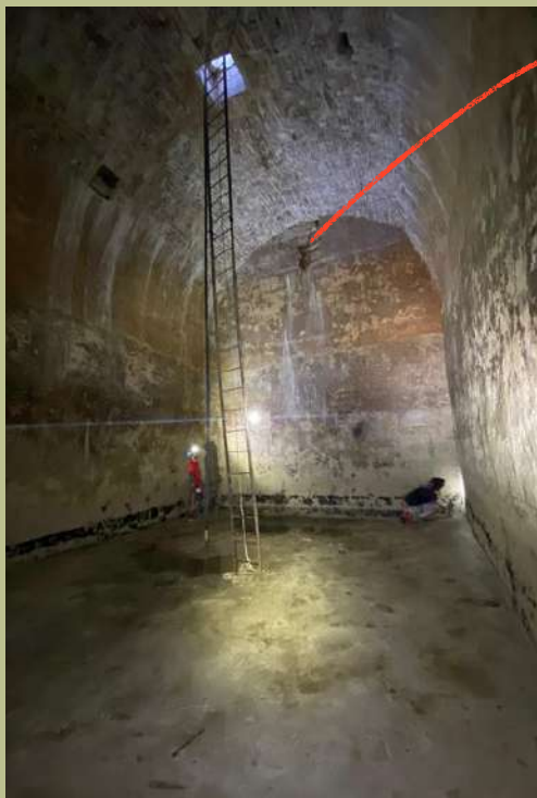
23. Vista complessiva dell'ambiente voltato
