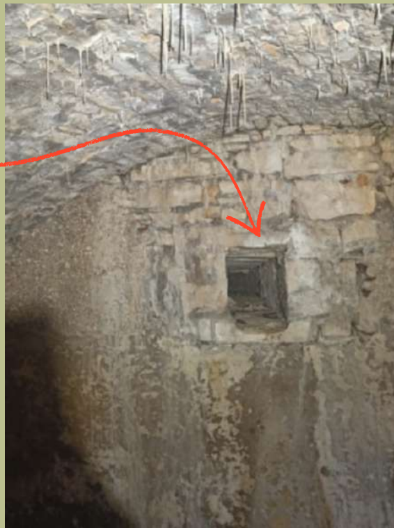
28. Particolare della bocchetta sul lato est della cisterna
