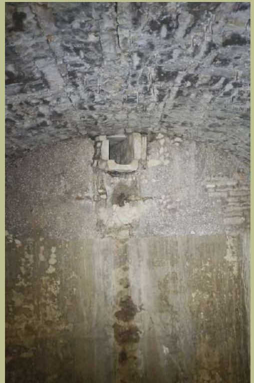
26. Particolare della bocchetta posta sul lato ovest della cisterna
