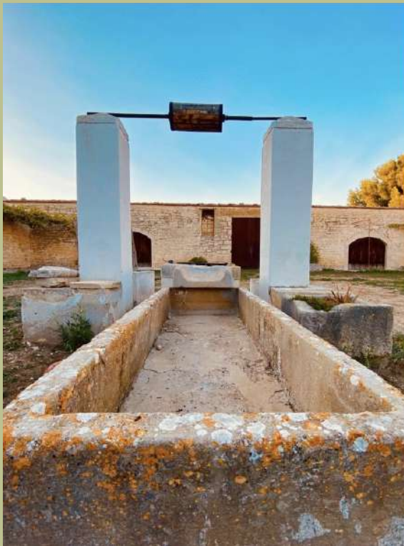
16. Cisterna a sinistra (entrando nella corte), vista frontale
