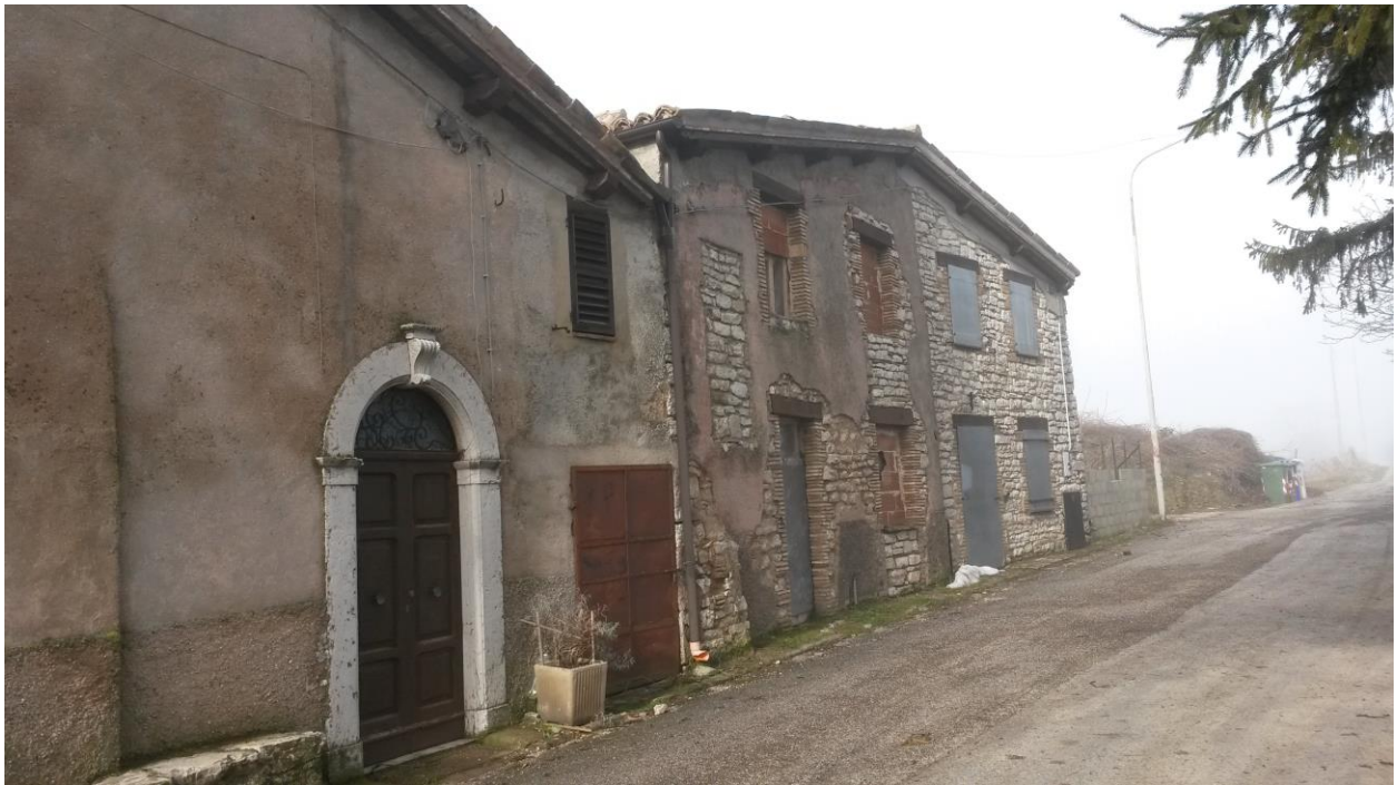
Frazione di Visso – le case hanno resistito esternamente ma all'interno sono crollate
